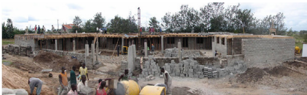
Casseri quasi ultimati; sulla lamiera vengono sistemate le armature, i tubi per gli impianti e i blocchi cavi per alleggerire la soletta (29 maggio)
