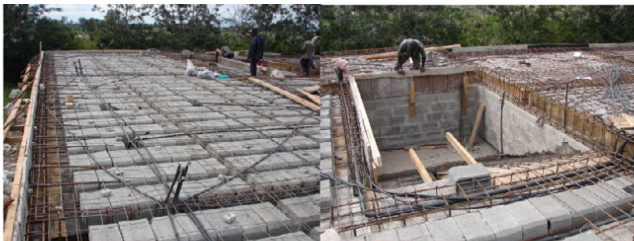
Armature, impianti e blocchi cavi per gli alleggerimenti. Anche il vano scala e' completo e pronto per il getto dell'ultima rampa. (29 maggio)
