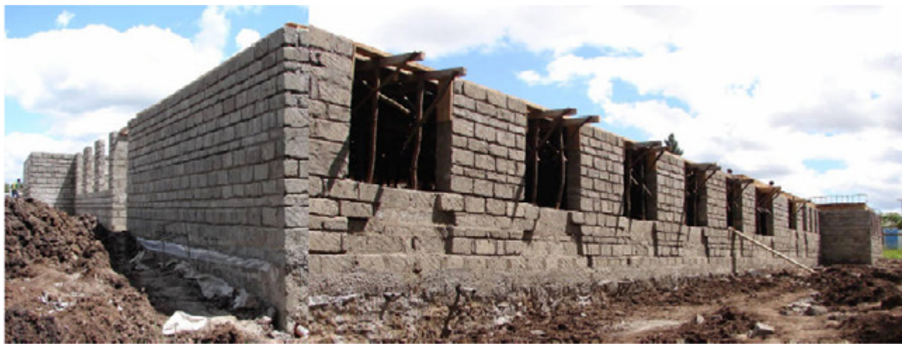
Tutte le pareti del pian terreno sono state completate. (foto 24 maggio)
