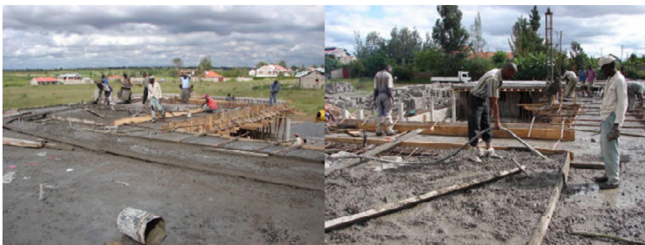
Il getto della soletta (foto 2 giugno) e' stato ultimato il 3 giugno. I lavori procedono ora con l'innalzamento dei muri del primo piano.
